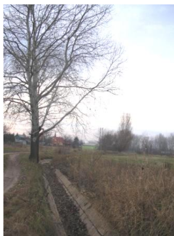
A csatorna Narancsízű sor felőli szakasza
